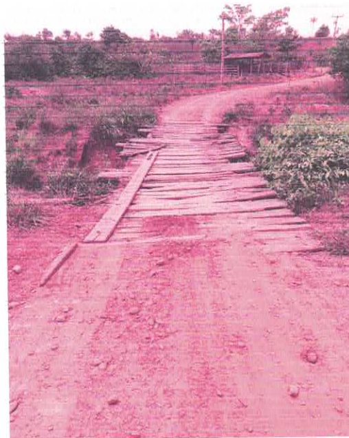
Imagem 06: Na altura do km 15,20. Trecho crítico sem revestimento laterítico, formação de erosão na pista de rolamento.
