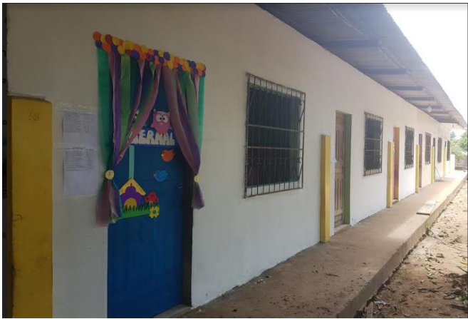
FIGURA 03-PAVILHÃO C/05 SALAS (PARTE DOS FUNDOS)
