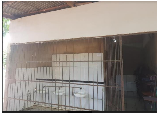
FIGURA 04- SALA DOS BANHEIROS E LAVATORIOS(AO LADO PAVILHAO)
