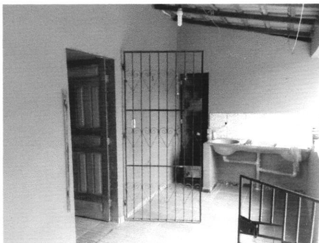
Figura 10 - PORTA DE ACESSO COM GRADES
