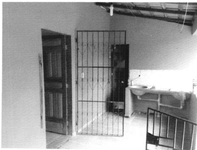
Figura 10 - PORTA DE ACESSO COM GRADES
