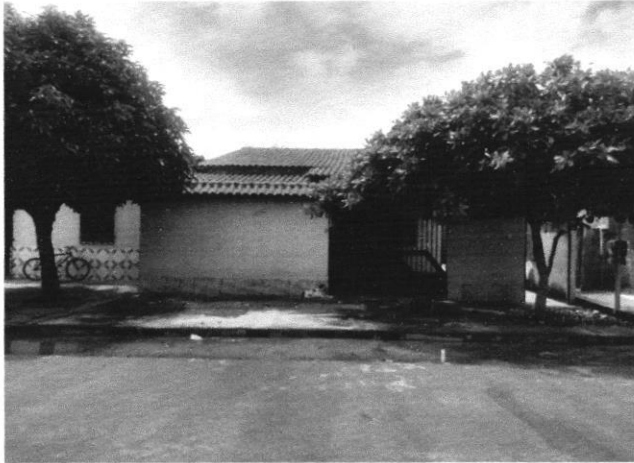
Figura 1 - VISÃO DA FRENTE DO IMÓVEL
