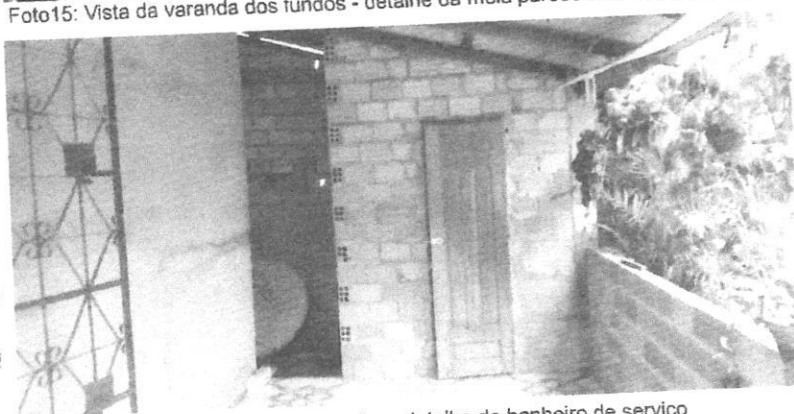
Foto16: Varanda dos fundos - detalhe do banheiro de serviço
