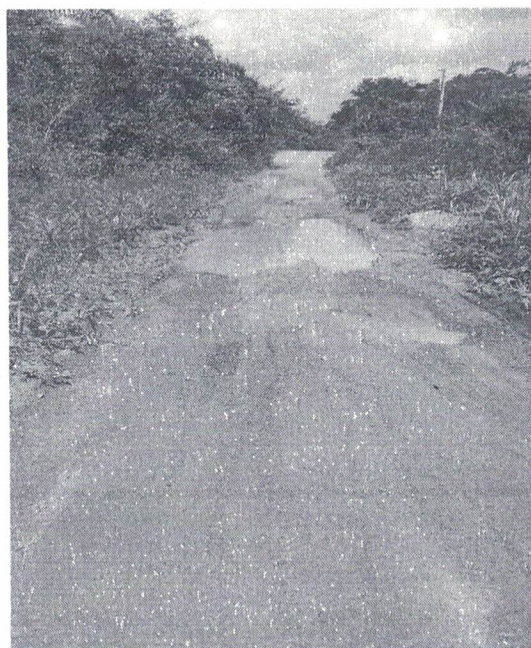
Imagem 03: Trecho crítico com poças d'água na altura do km 3,30, fazer BSTC = Ø60.
