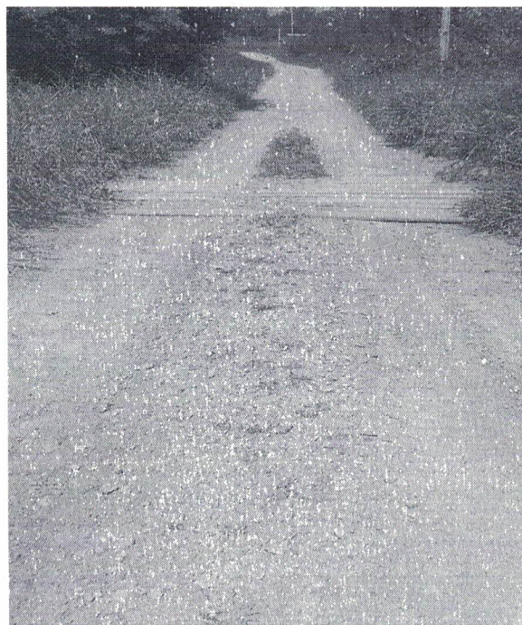
Imagem 13: Pinguela em toras de madeira na altura do km 13,40, substituir por BSTC = Ø60.
