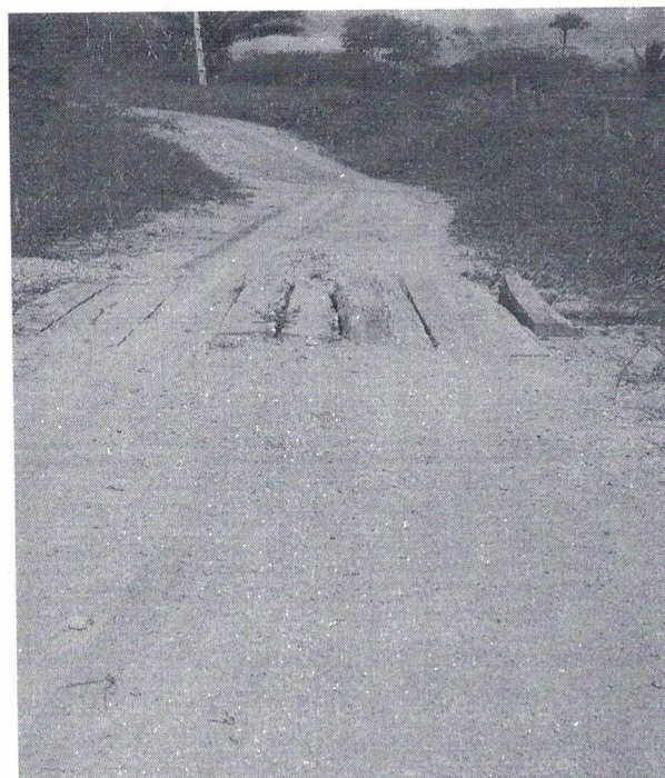
Imagem 9: Pinguela em toras de madeira na altura do km 10,70. Substituir por BSTC = Ø60
