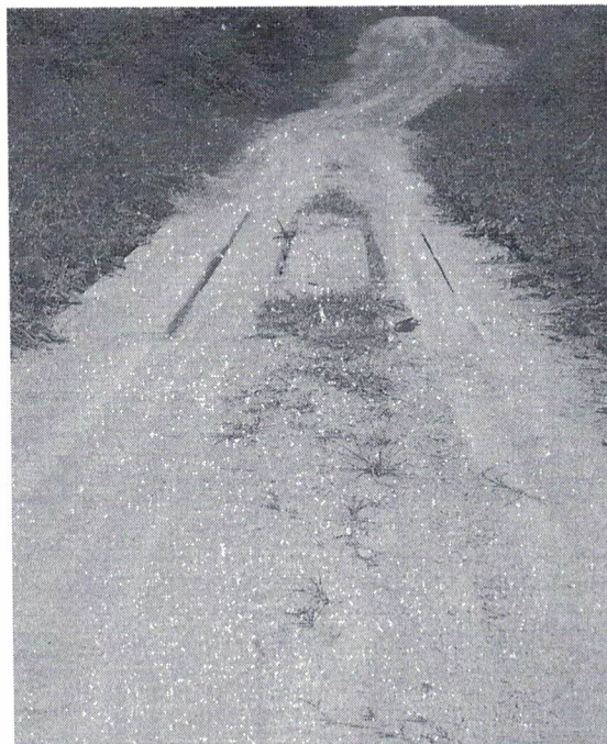
Imagem 11: Pinguela em toras de madeira na altura do km 11,90. Está em bom estado.
