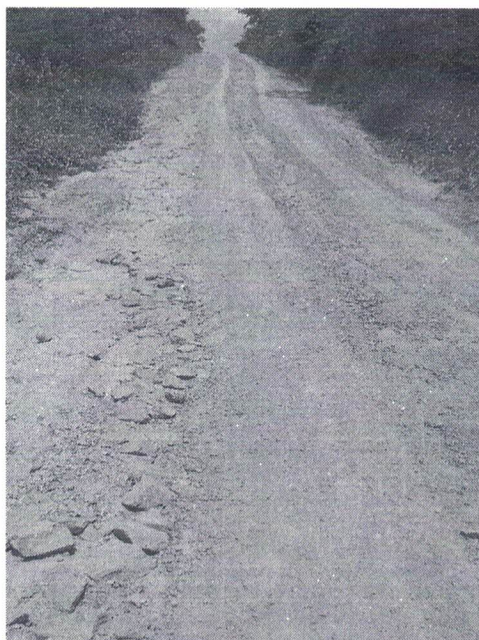
Imagem 04: Ladeira sem revestimento primário na altura do km 4,30.
