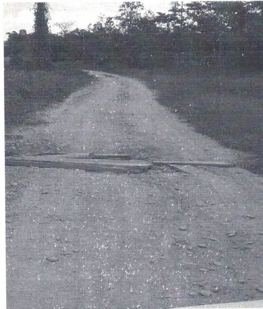
Imagem 22: Pequena Pinguela na altura do km 36,1. Substituir por BSTC Ø60.
