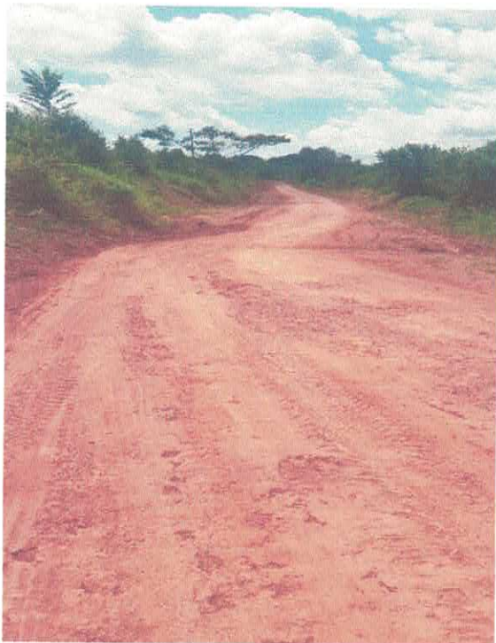
Trecho critico km 4,40 Pimental
