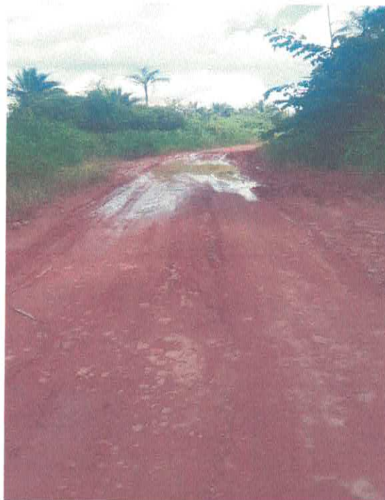
Trecho critico km 37,90 Pimental
