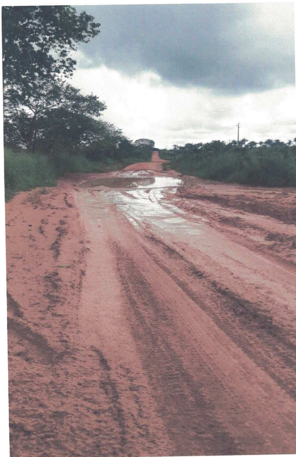
Imagem no km 33,90 - Atoleiro e falta de aterro com revestimento
