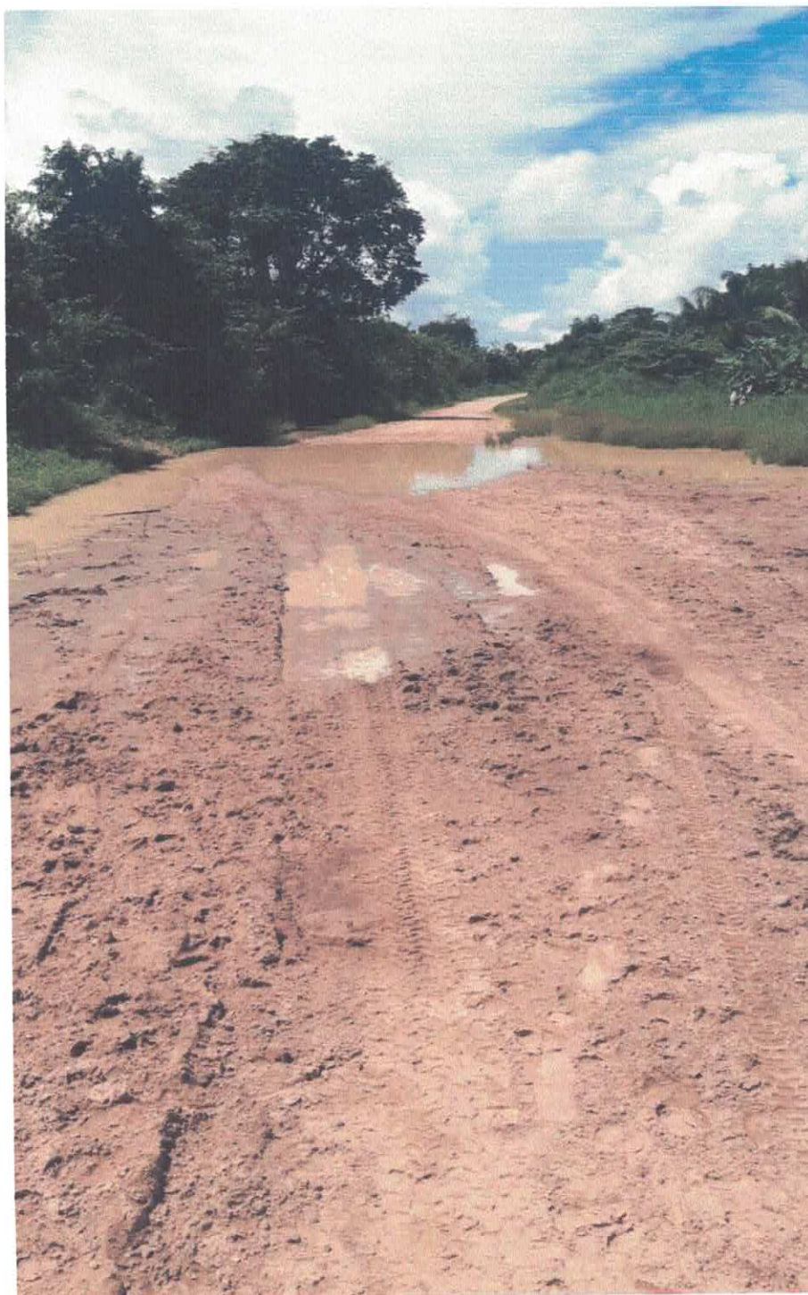
Imagem no km 57,10 - Atoleiro onde falta aterro e revestimento laterítico
