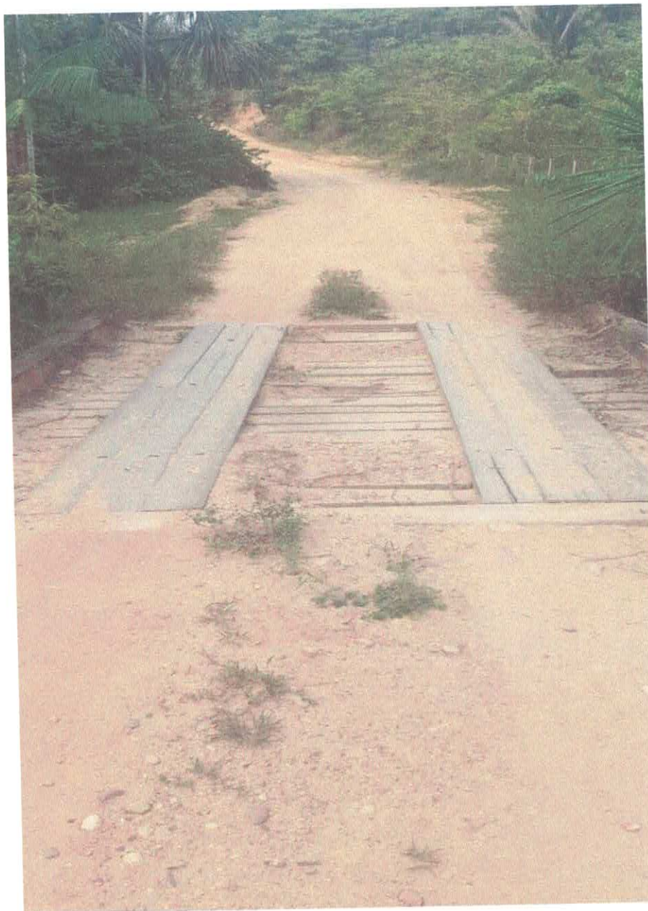
Imagem 12: Pequena ponte que será trocada por bueiro tubular duplo na altura do km 28,80.
