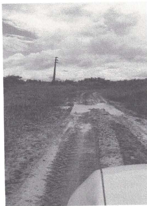
Imagem 05: Trecho necessitando de bueiro simples de 60 para acabar com atoleiro já se formando na altura do km 20,40.
