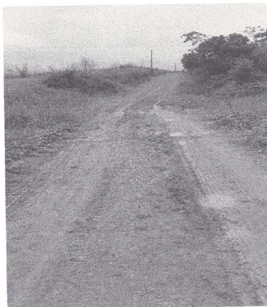
Imagem 07: Trecho crítico onde não há revestimento laterítico e a vegetação encobre a lateral da estrada em toda sua extensão na altura do km 43,50.
